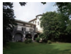
グリーンハウス南面テラス
