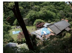
屋根修復工事中の母屋
