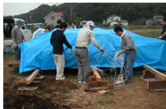
市民活動の様子/旧三井別邸(大磯町) 解体保存した部材の養生作業
