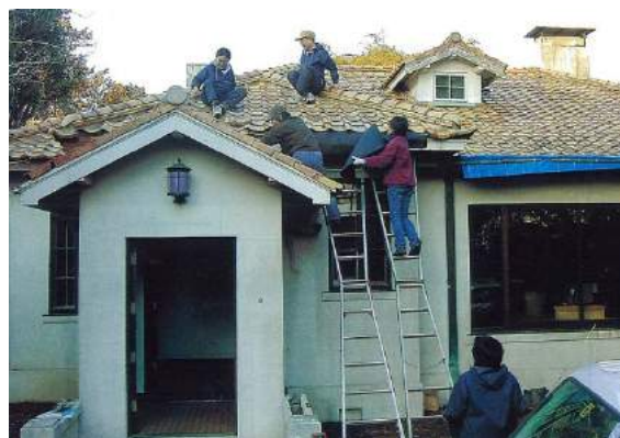
市民活動の様子/旧モーガン邸(藤沢市) ボランティアによる雨漏りの応急修理
